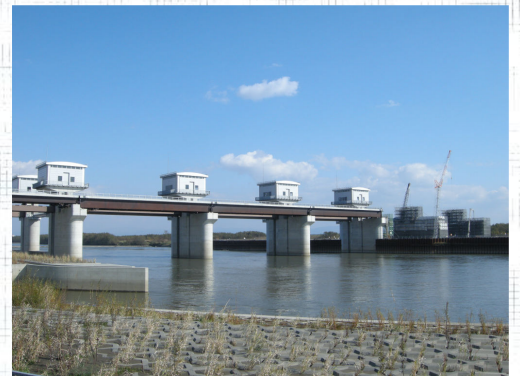
建設中の新・石狩川頭首工
