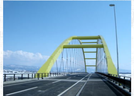
開通した美浦大橋 (3/26)
